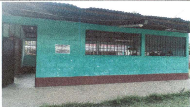
Foto1: Cambio de cubierta de lamina
