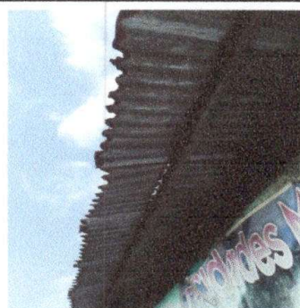
Foto 2: Cambio de cubierta de lamina
