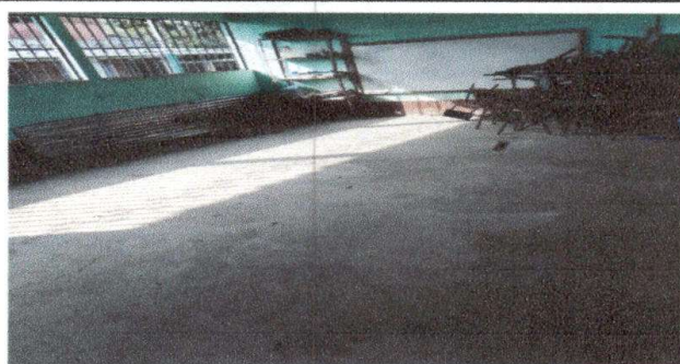
Foto 6: Sustitución de piso cerámico
