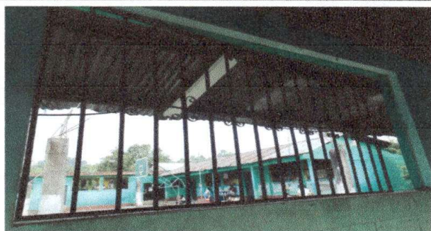
Foto 5: Sustitución de balcones de metal
