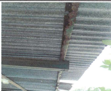
Foto 3: Cambio de estructura de Techo
