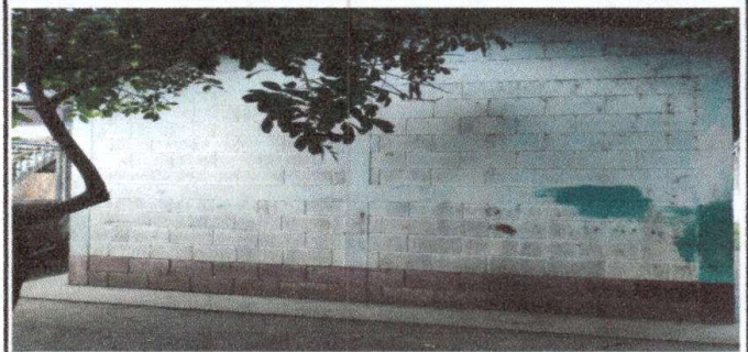
Foto 8: Pintura en muros exteriores e interiores
