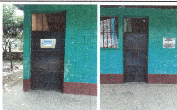
Foto 4: Sustitución de puertas
