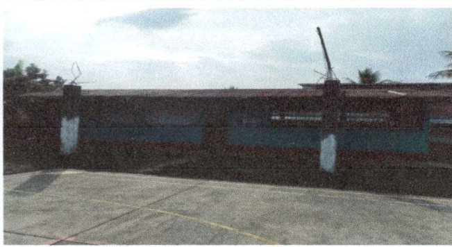
Foto 7: Sustrucción de Canal de Metal
